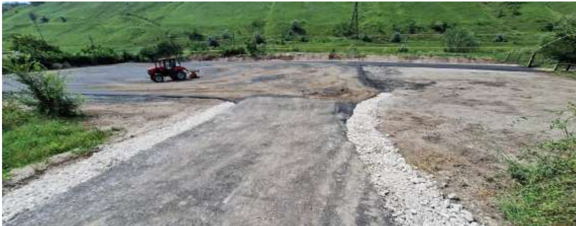
Lucrări de asfaltare executate la str. Nistreană, mun. Orhei
